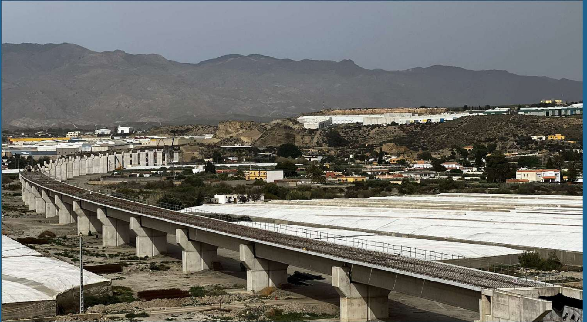
VIADUCTO SOBRE EL RIO ANDARAX 1
