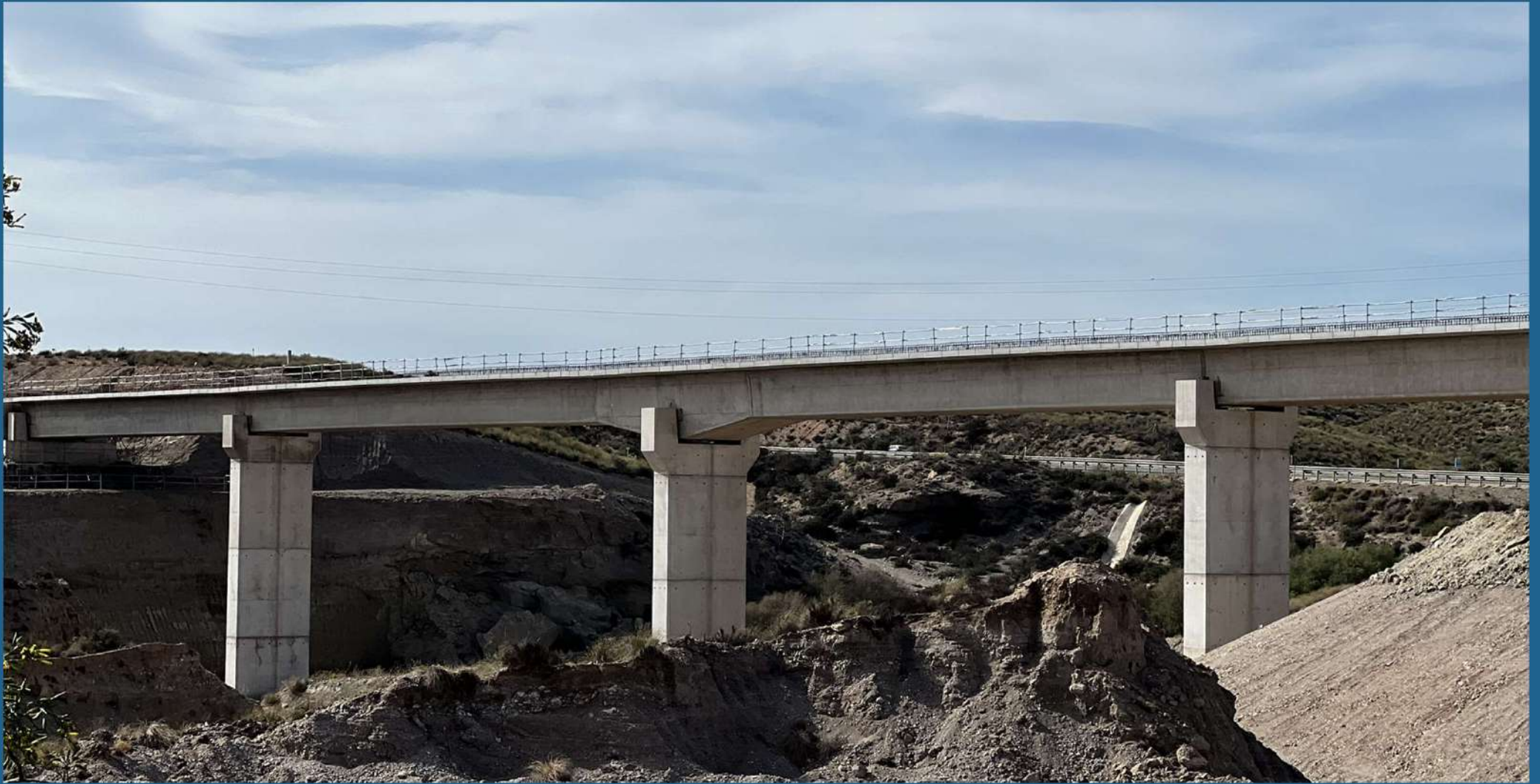
VIADUCTO SOBRE RAMBLA DEL PUENTE QUEBRADA (2)
