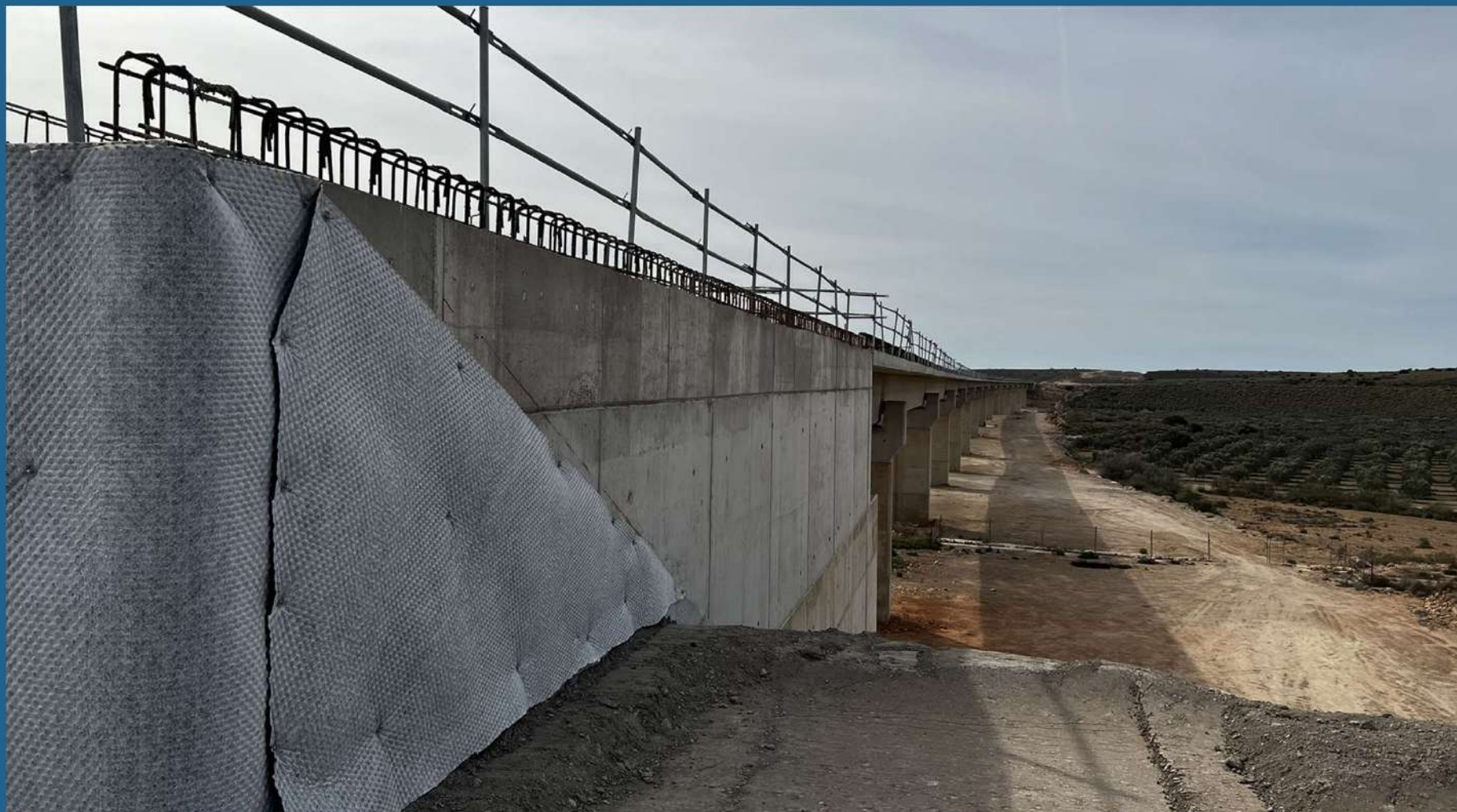
VIADUCTO SOBRE RAMBLA DEL MALTÉS
