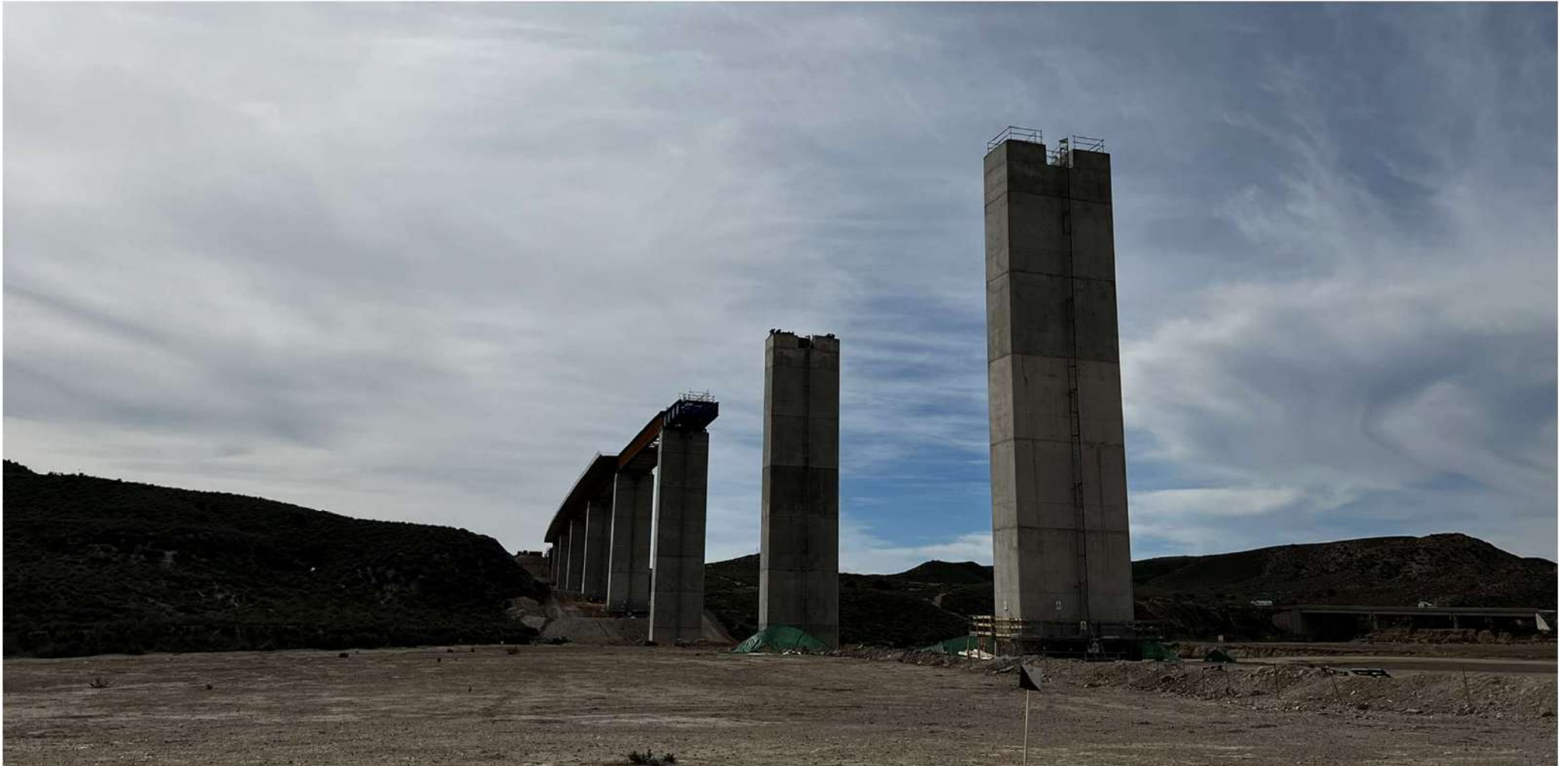
VIADUCTO RAMBLA DE LOS FEOS (1)
