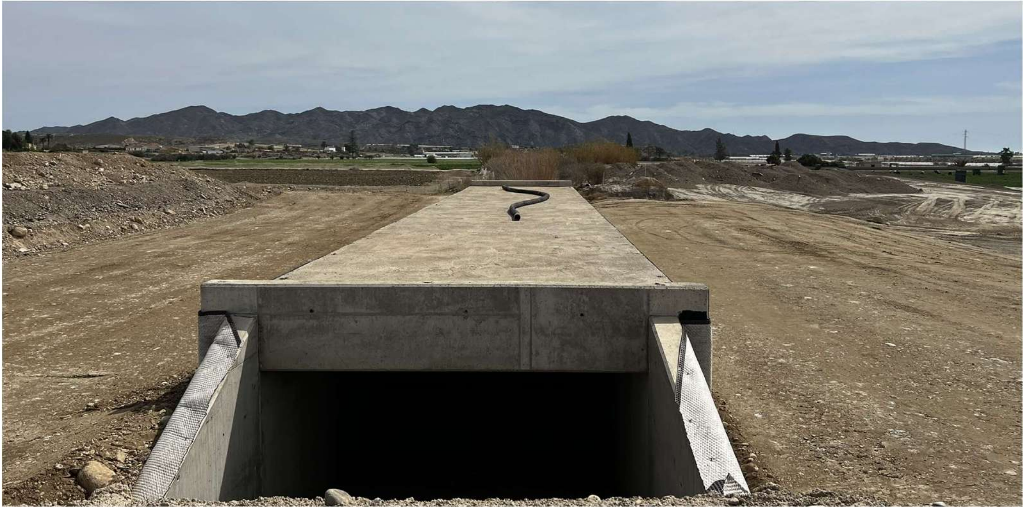
OBRA DE PASO_5
