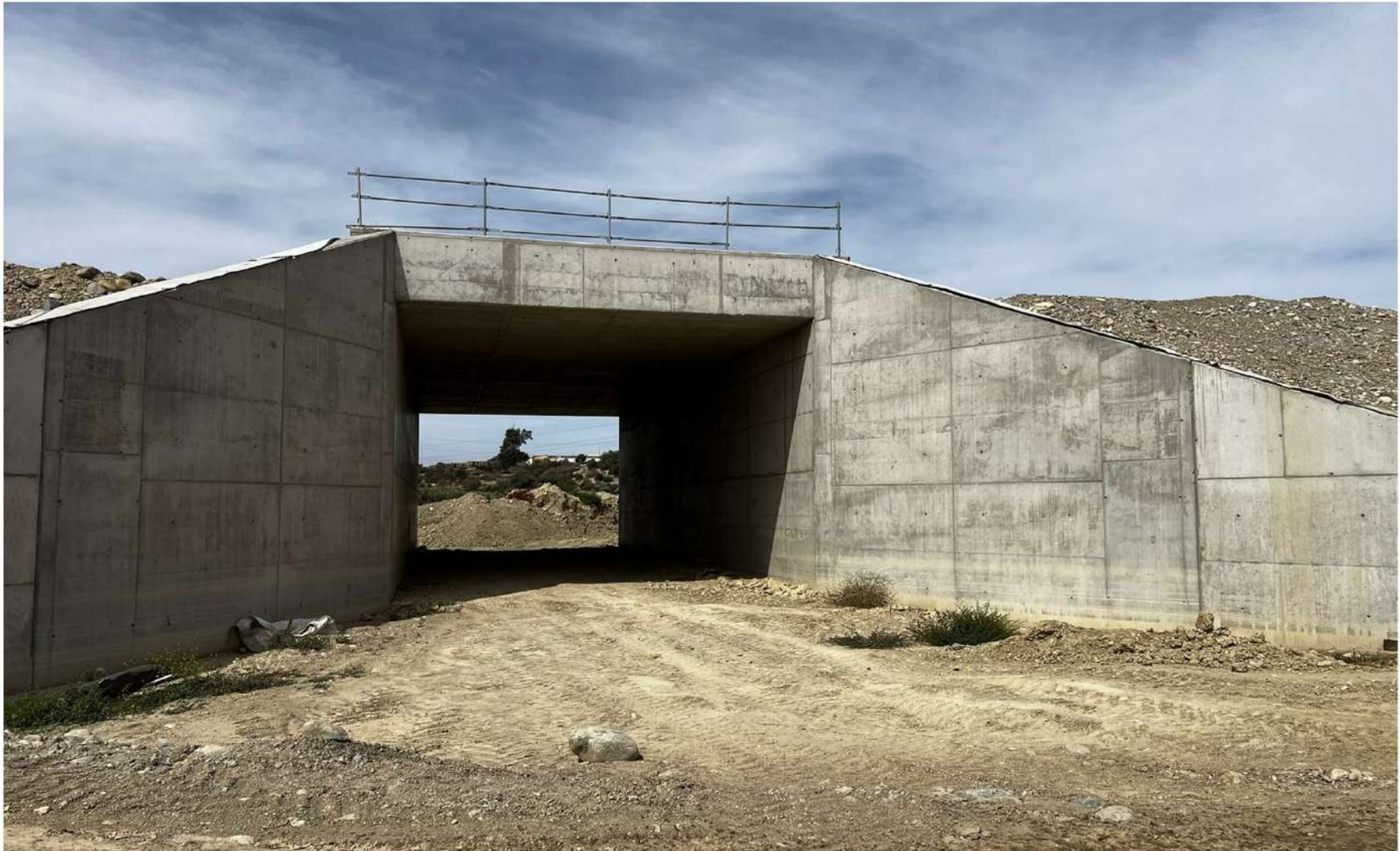
OBRA DE PASO_2
