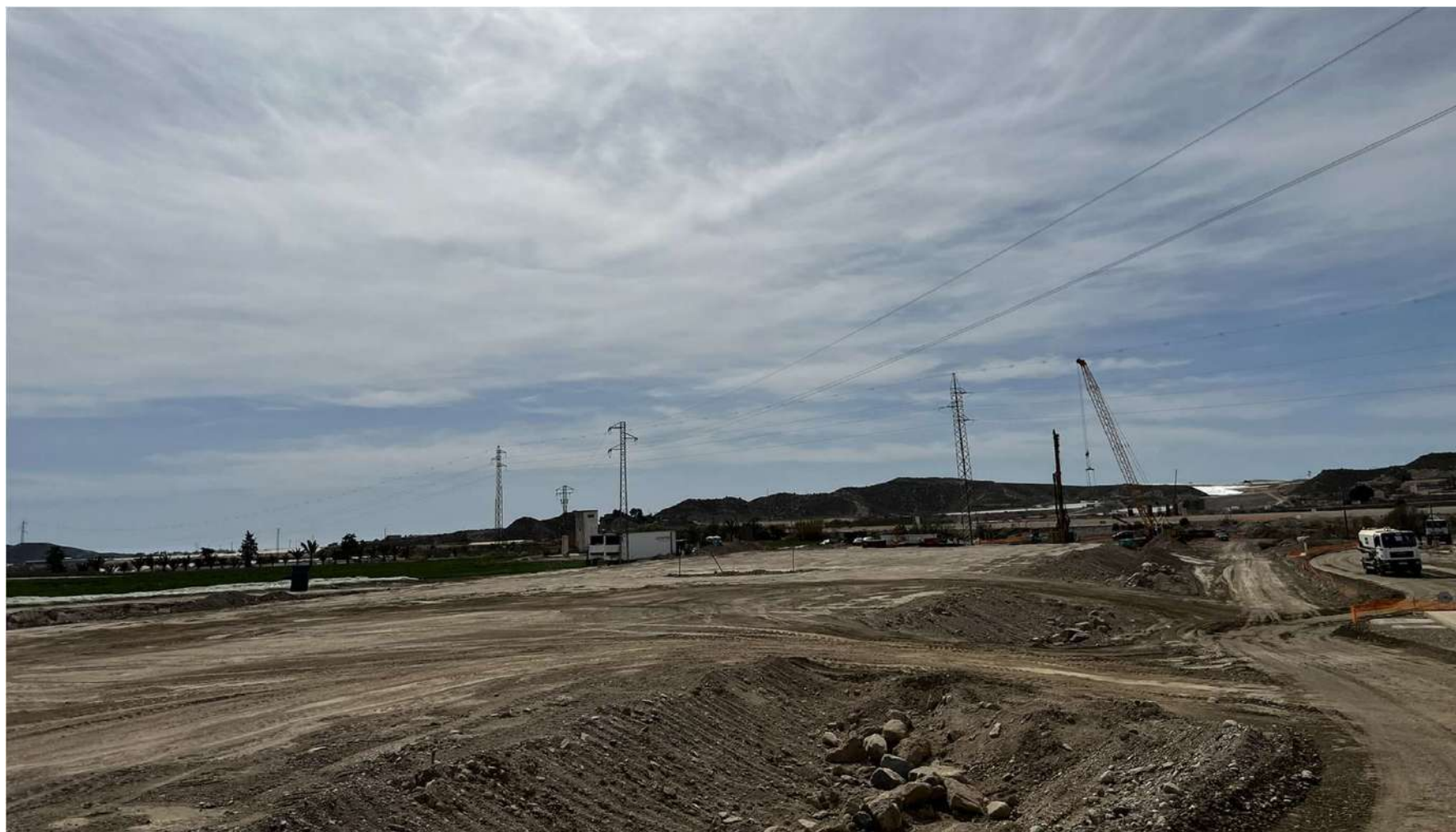
CIMENTACIÓN PUENTE SOBRE RÍO ALMANZORA_1
