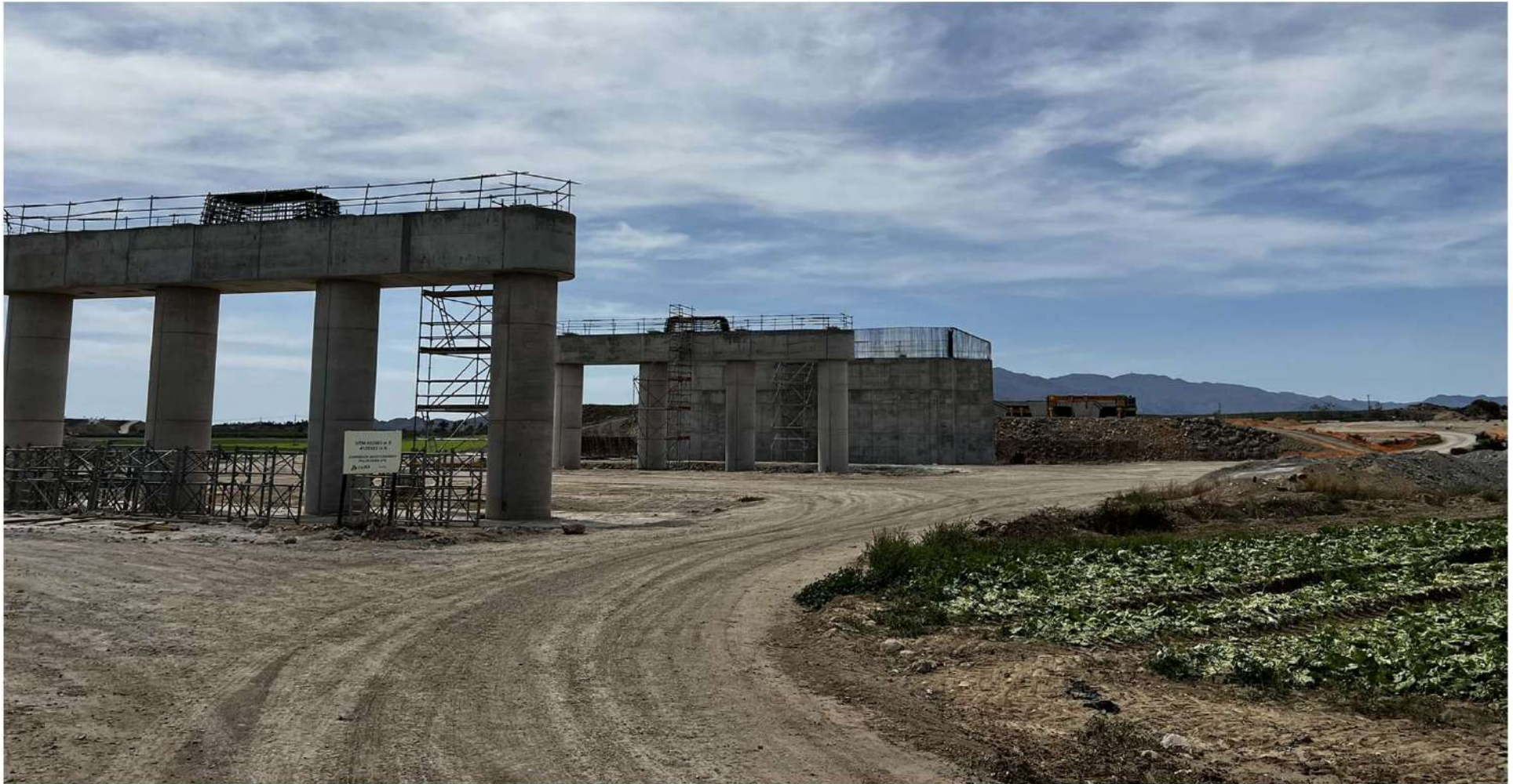
PUENTE SOBRE AUTOVÍA A-352 Y JUNTO A ESTACIÓN DE VERA
