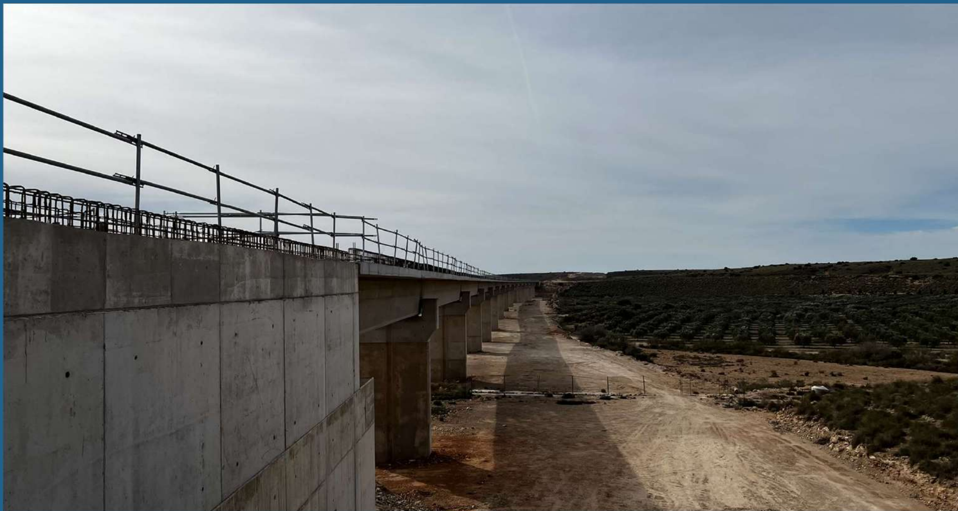
VIADUCTO SOBRE RAMBLA DEL MALTÉS (1)
