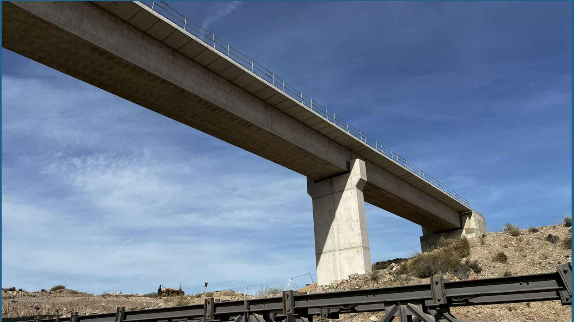
VIADUCTO SOBRE RAMBLA DEL PUENTE QUEBRADA (1)
