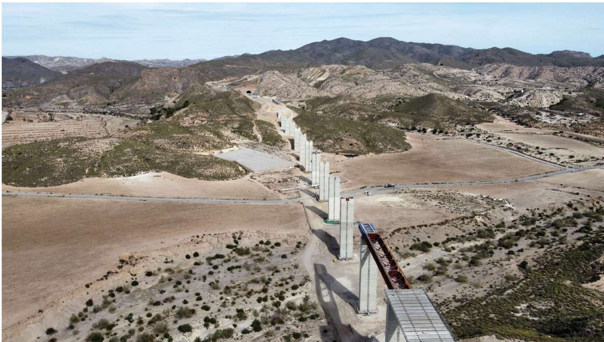
VIADUCTO RAMBLA DE LOS FEOS (5)
