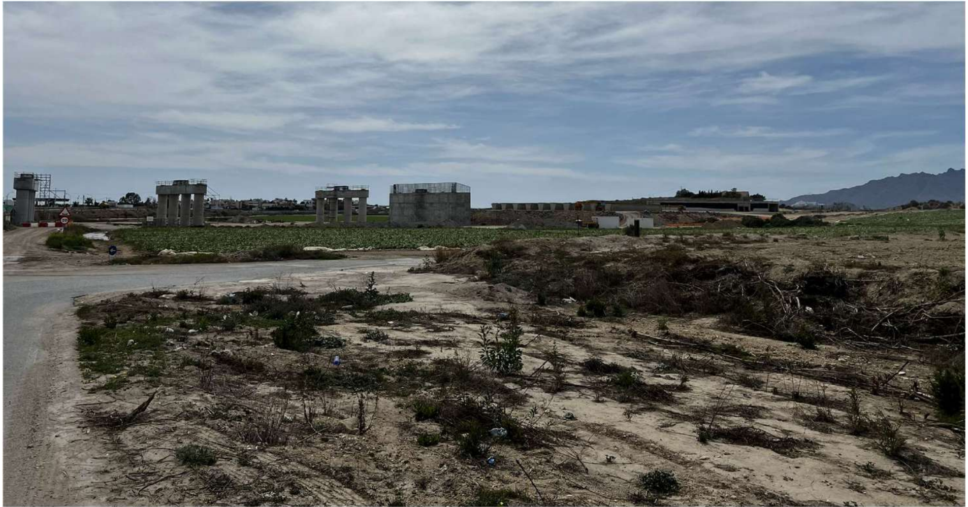
PUENTE SOBRE AUTOVÍA A-352 Y JUNTO A ESTACIÓN DE VERA_2
