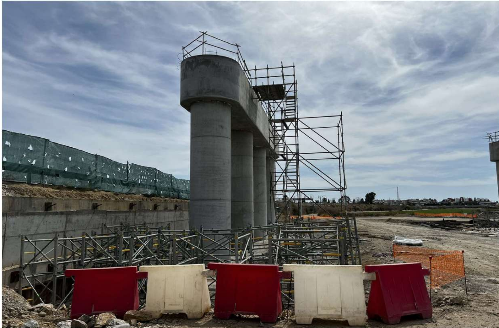
PUENTE SOBRE AUTOVÍA A-352 Y JUNTO A ESTACIÓN DE VERA_4
