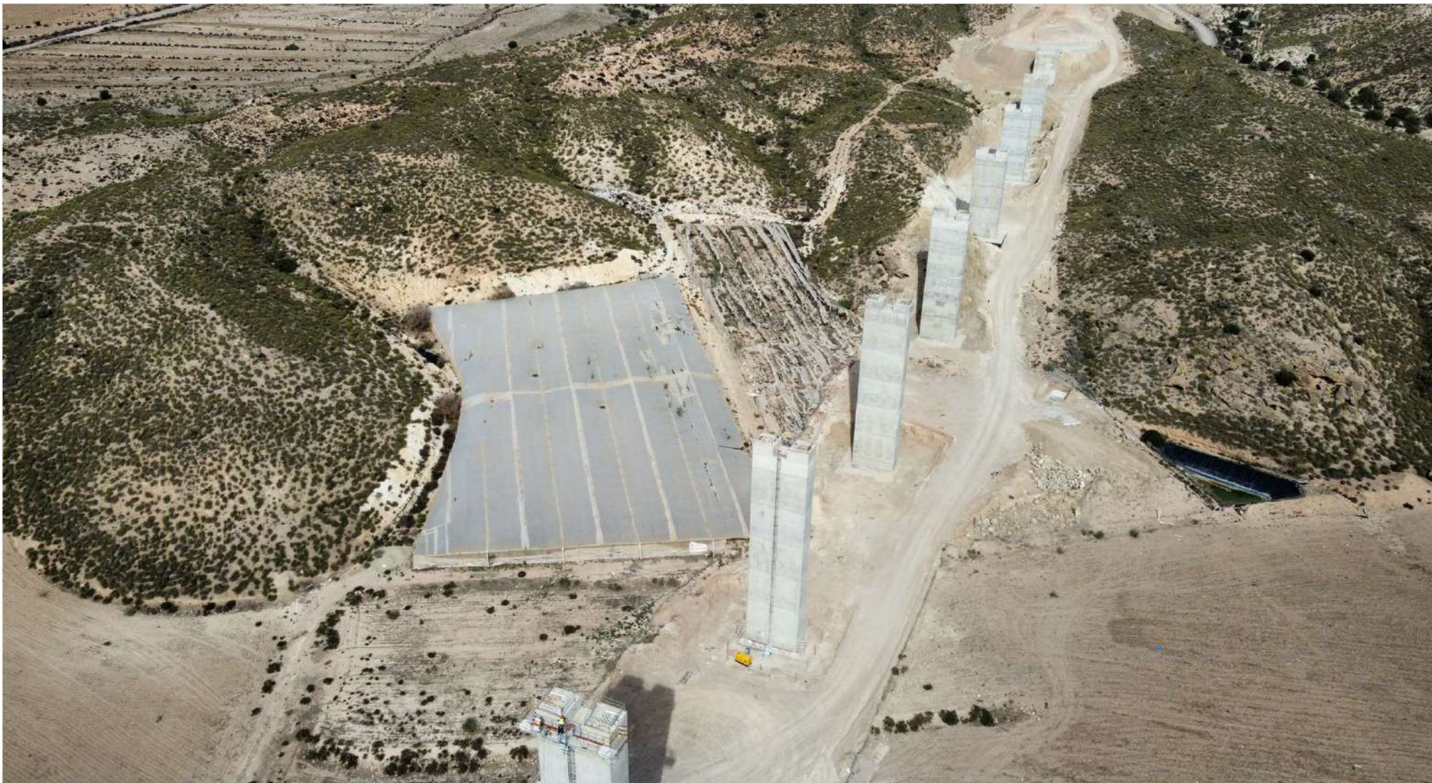
VIADUCTO RAMBLA DE LOS FEOS (10)
