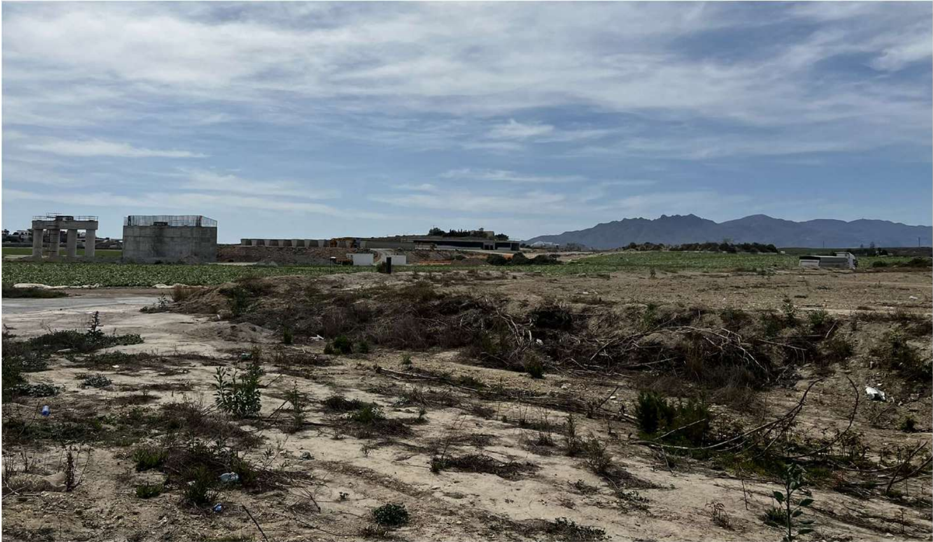
PUENTE SOBRE AUTOVÍA A-352 Y JUNTO A ESTACIÓN DE VERA_3
