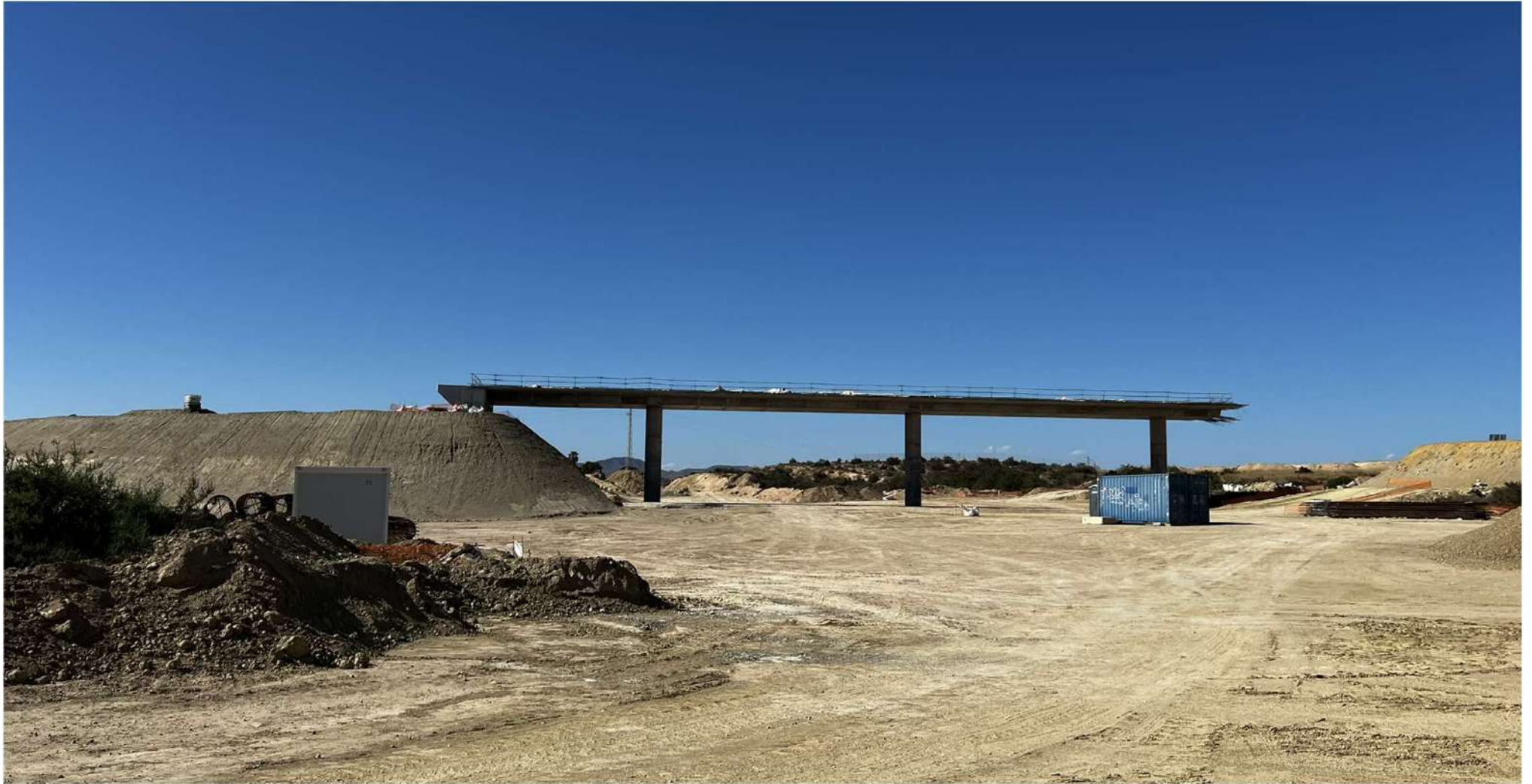
PUENTE SOBRE PLATAFORMA EN PULPÍ
