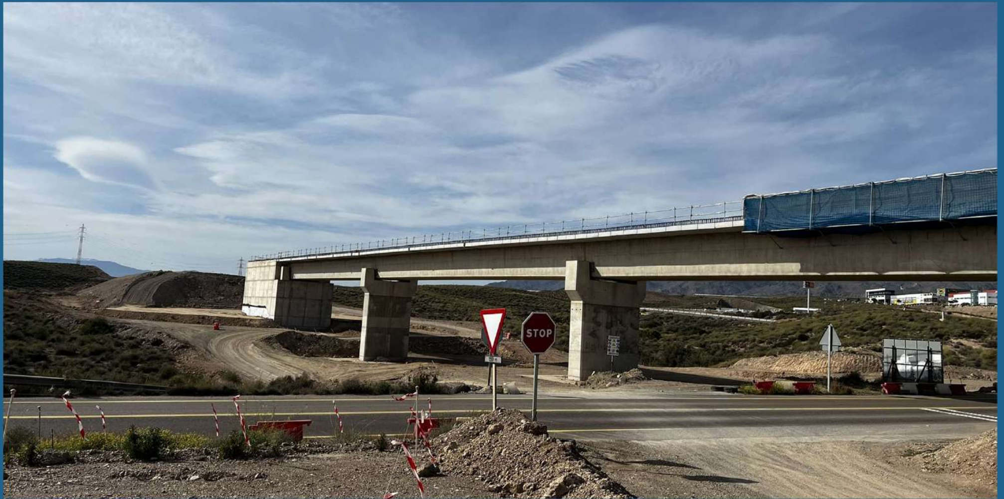
VIADUCTO SOBRE RAMBLA DE LA SEPULTURA
