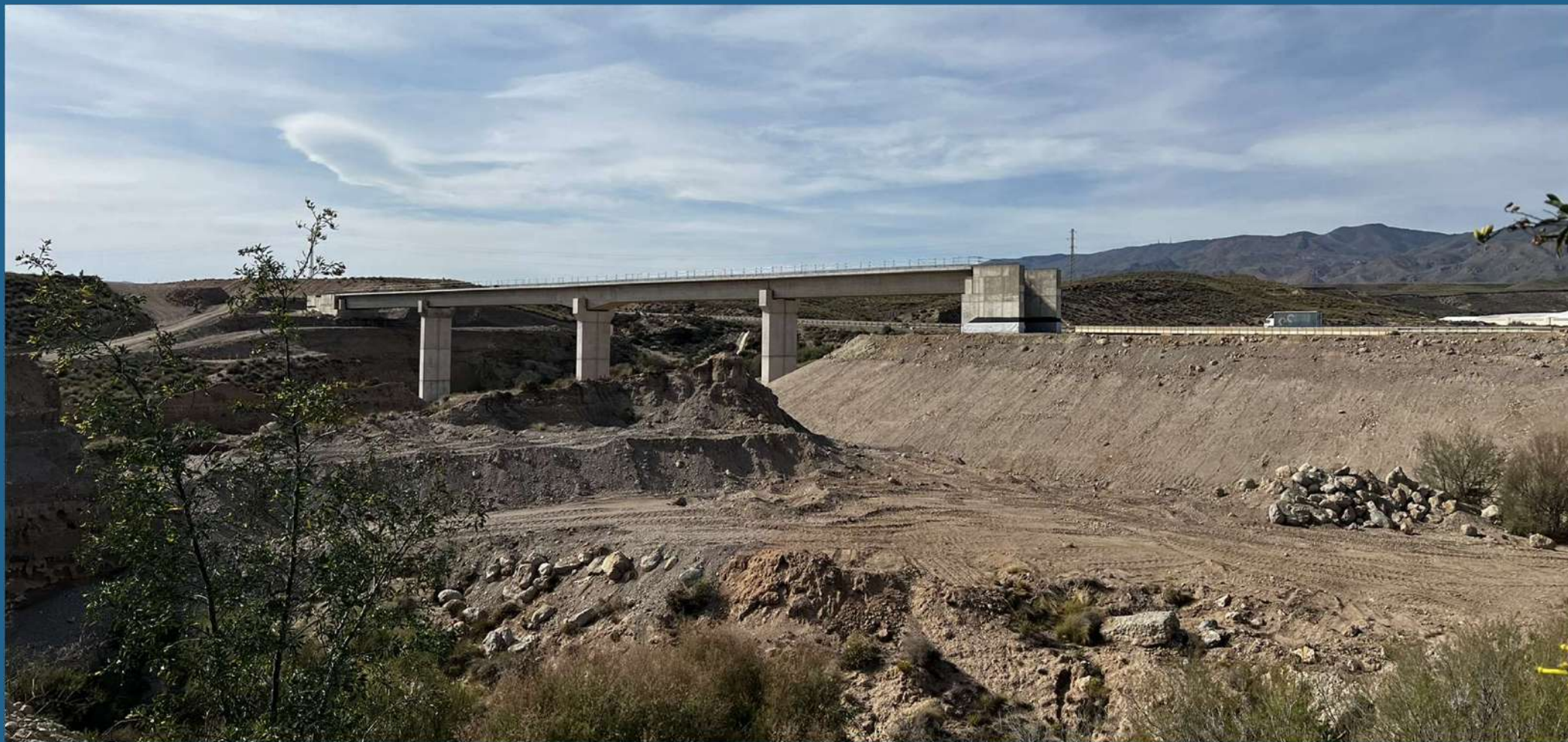
VIADUCTO SOBRE RAMBLA DEL PUENTE QUEBRADA
