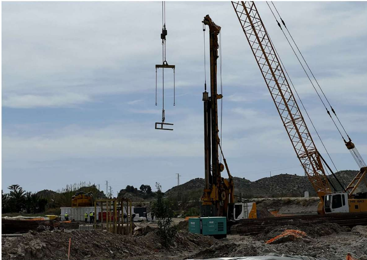
CIMENTACIÓN PUENTE SOBRE RÍO ALMANZORA_2
