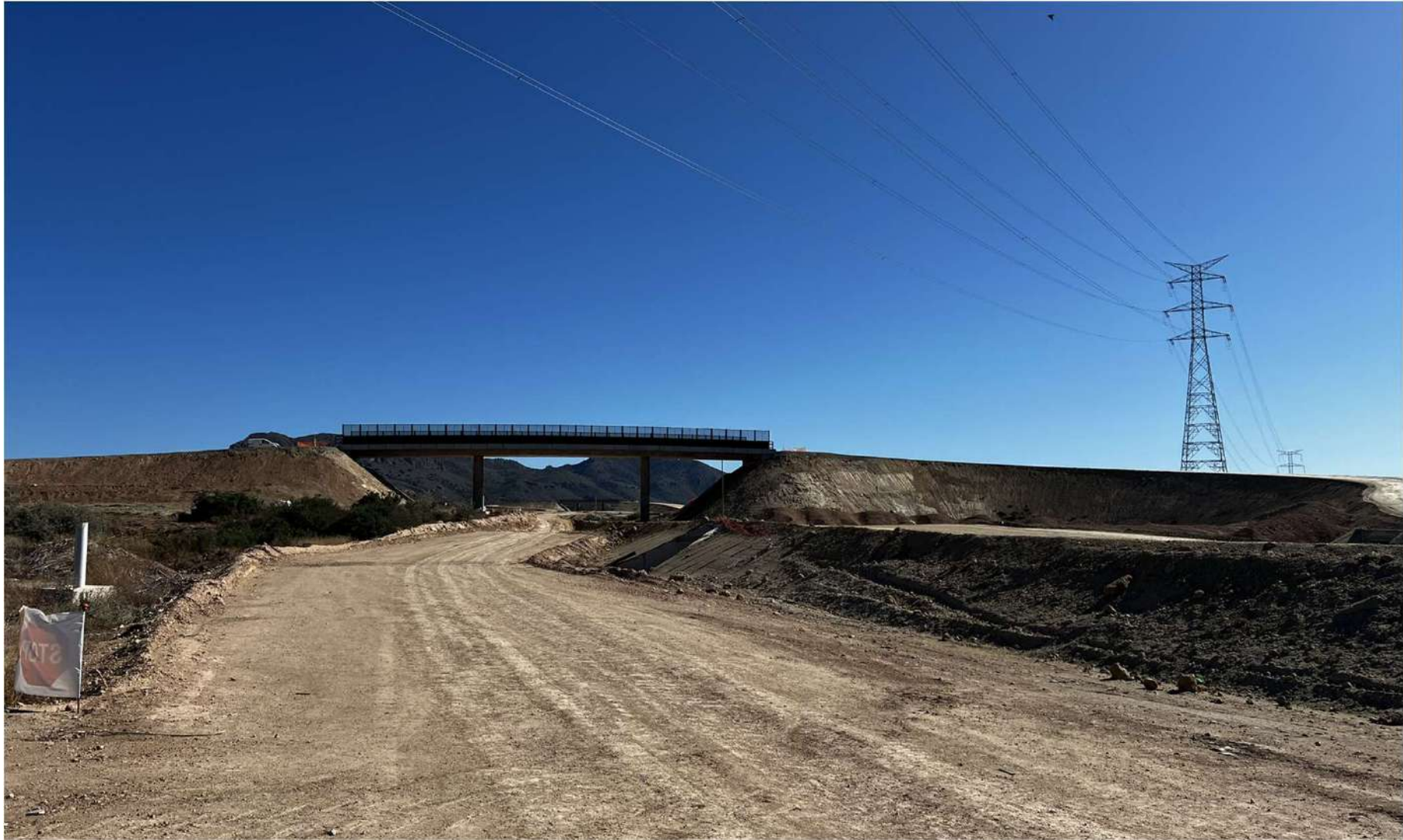
PUENTE SOBRE PLATAFORMA EN DULCE
