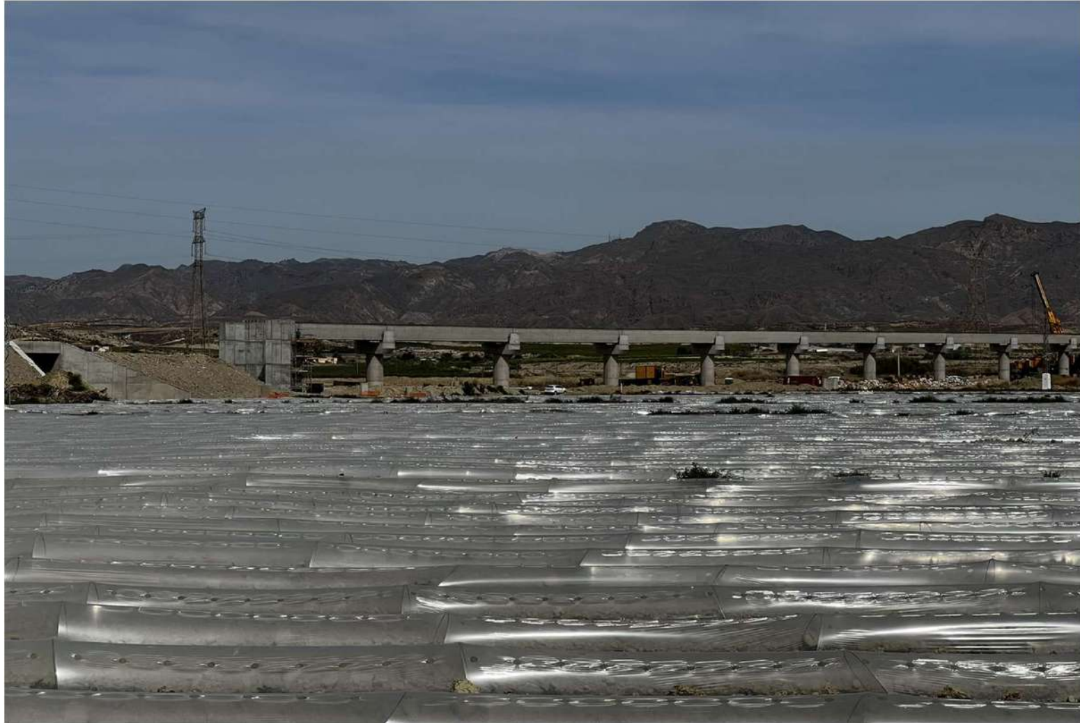
COLOCACIÓN DE VIGAS EN VIADUCTO
