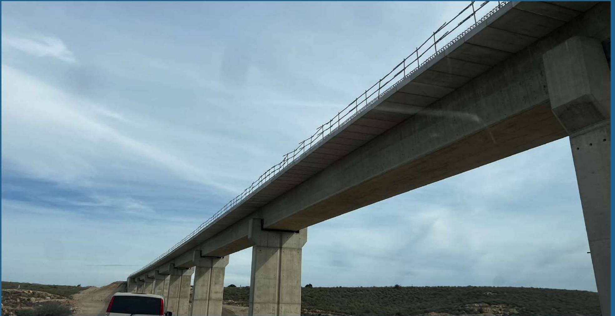
VIADUCTO SOBRE RAMBLA DEL MALTÉS (3)
