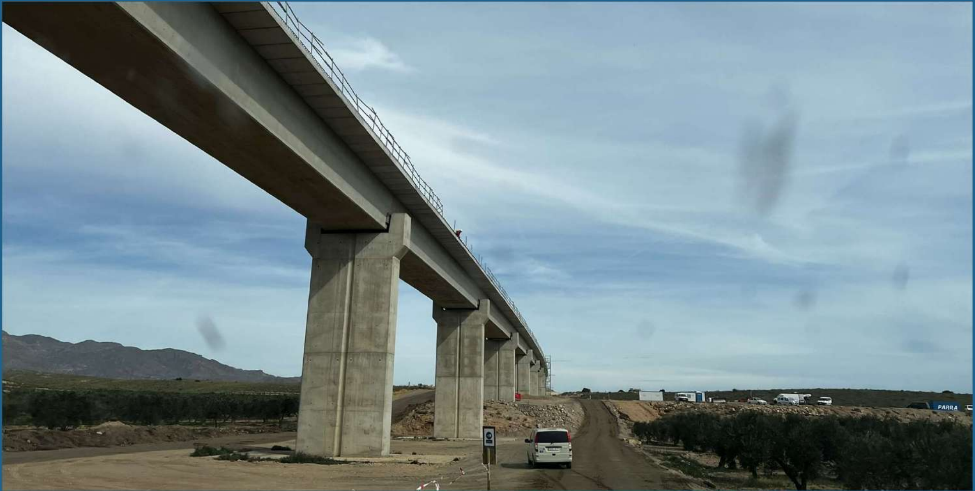
VIADUCTO SOBRE RAMBLA DEL MALTÉS (2)
