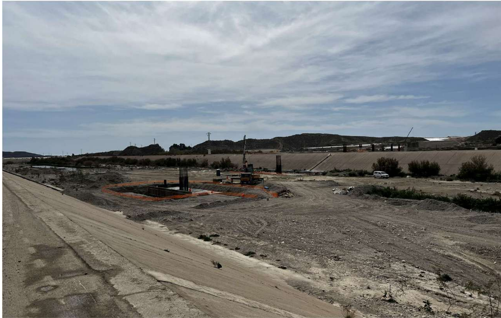
CIMENTACIÓN PUENTE SOBRE RÍO ALMANZORA
