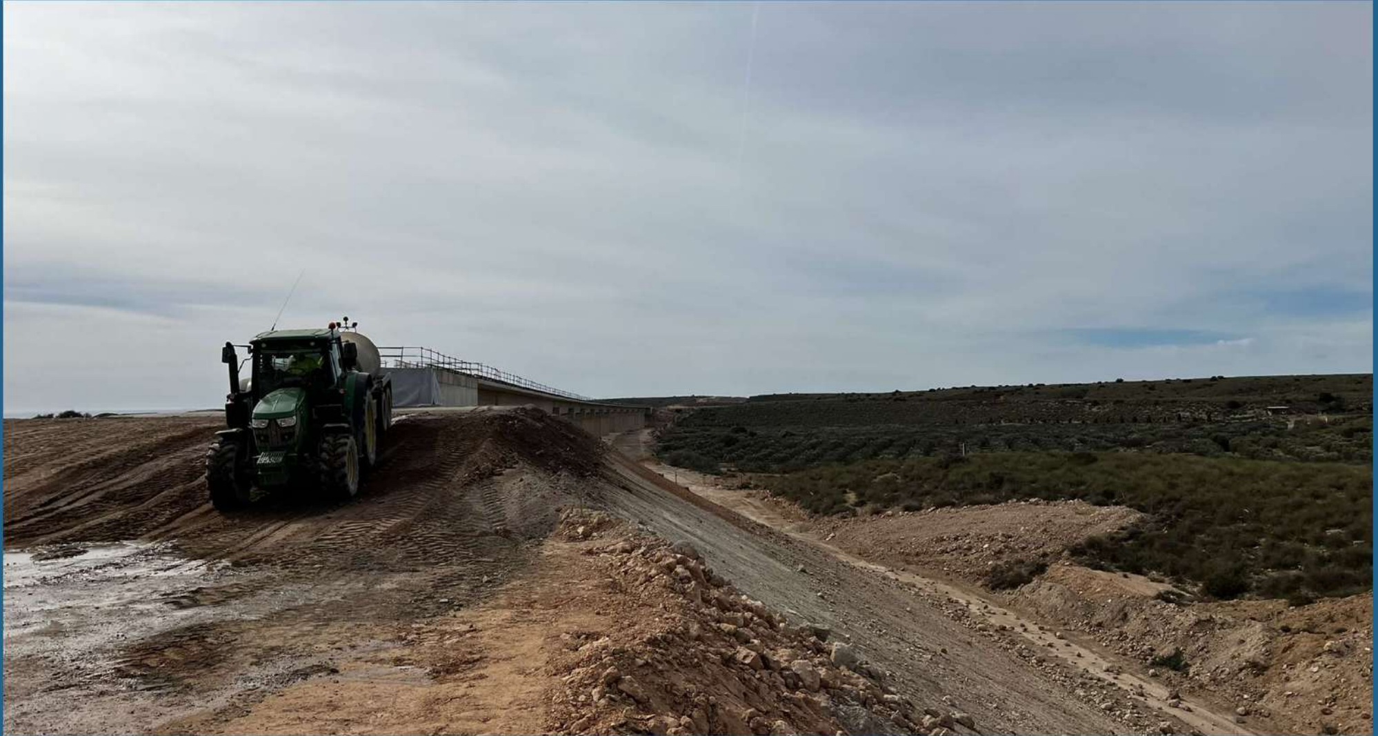
VIADUCTO SOBRE RAMBLA DEL MALTÉS (4)
