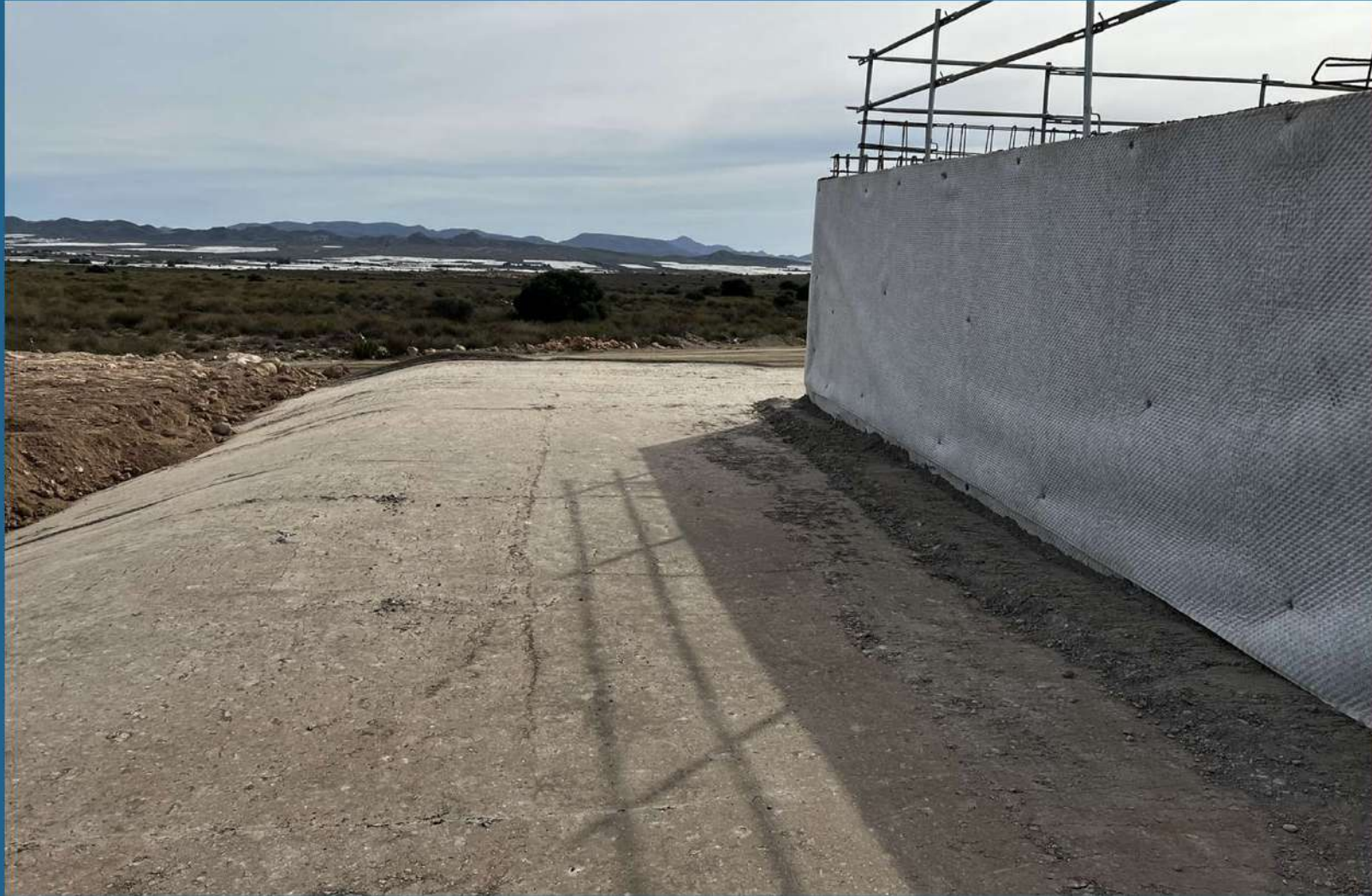
VIADUCTO SOBRE RAMBLA DEL MALTÉS (5)
