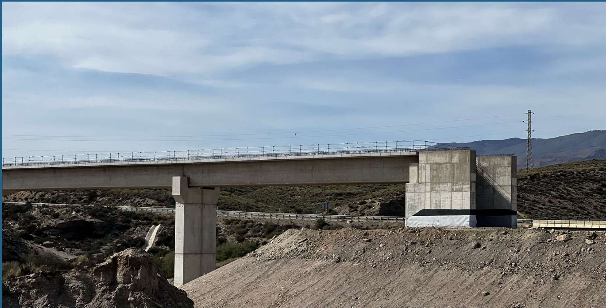
VIADUCTO SOBRE RAMBLA DEL PUENTE QUEBRADA (3)
