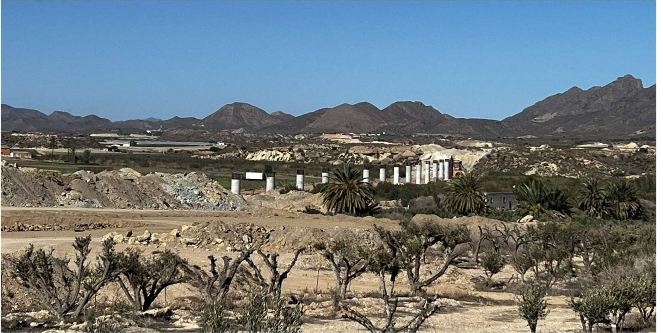
PILAS DE VIADUCTO
