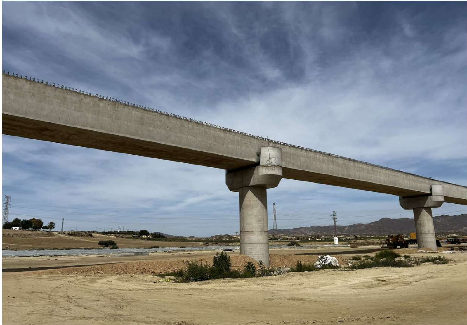
COLOCACIÓN DE VIGAS EN VIADUCTO_4
