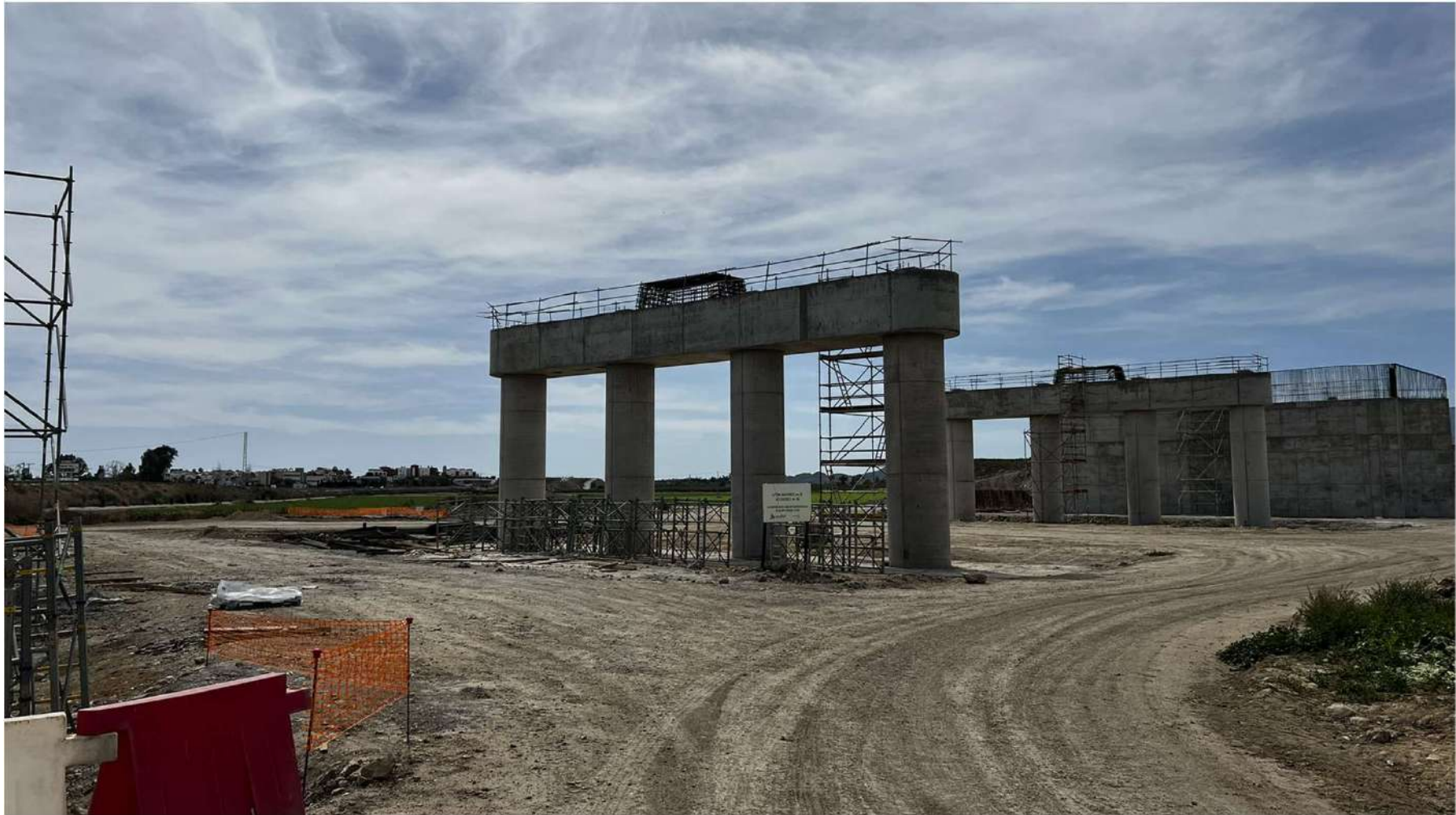
PUENTE SOBRE AUTOVÍA A-352 Y JUNTO A ESTACIÓN DE VERA_5
