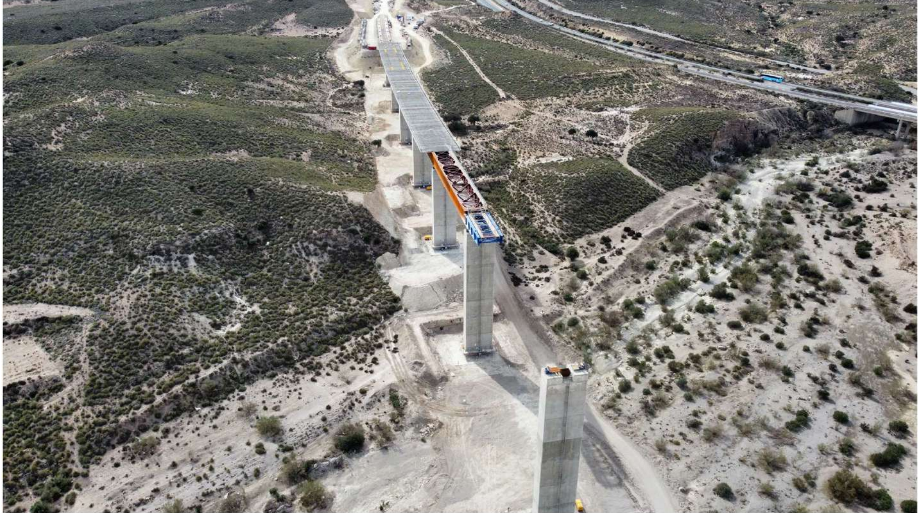
VIADUCTO RAMBLA DE LOS FEOS (1)
