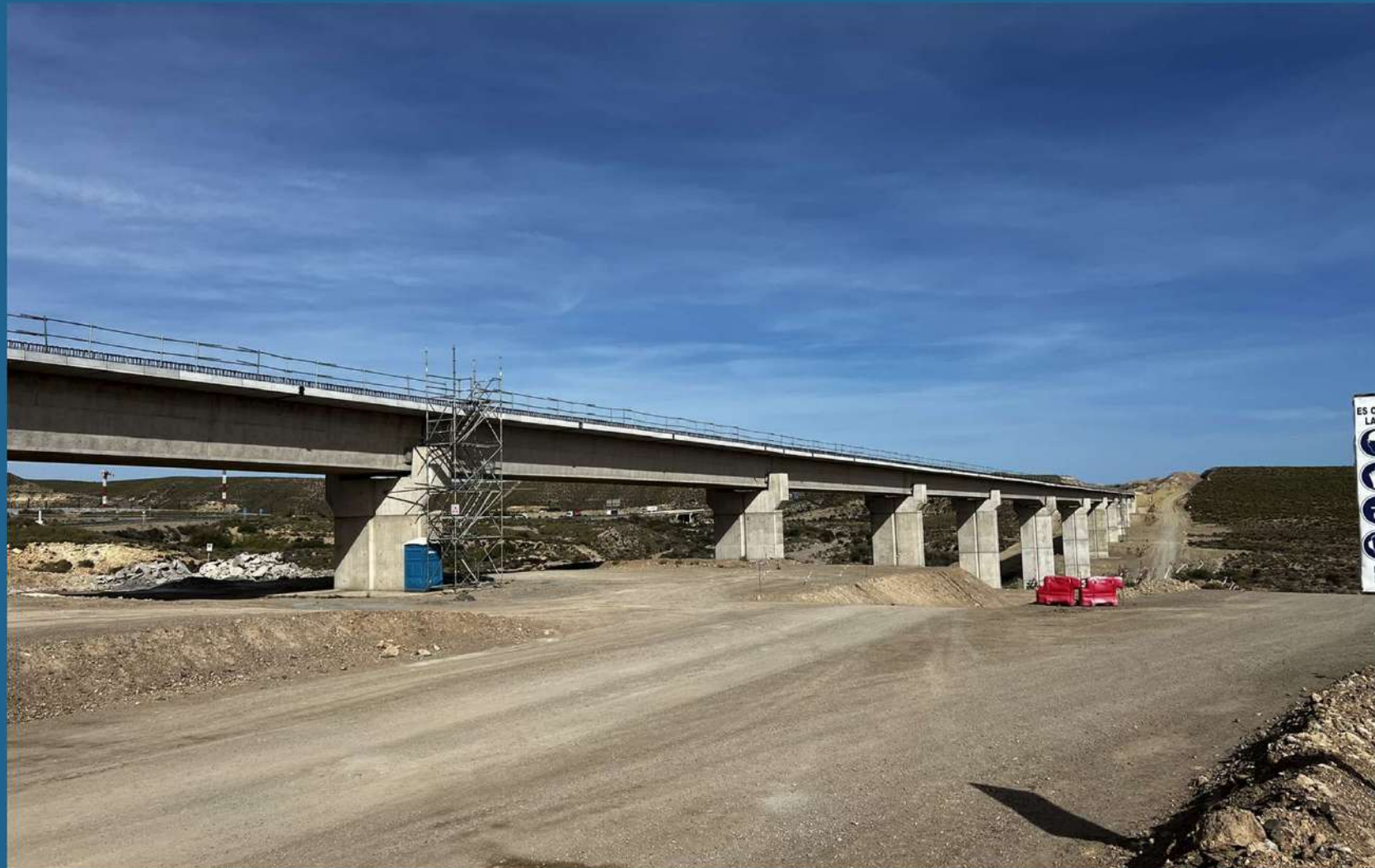
VIADUCTO SOBRE RAMBLA DE LA SEPULTURA
