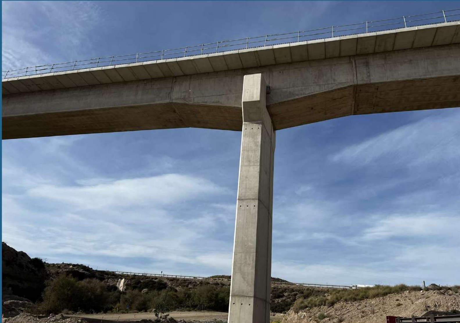
VIADUCTO SOBRE RAMBLA DEL PUENTE QUEBRADA
