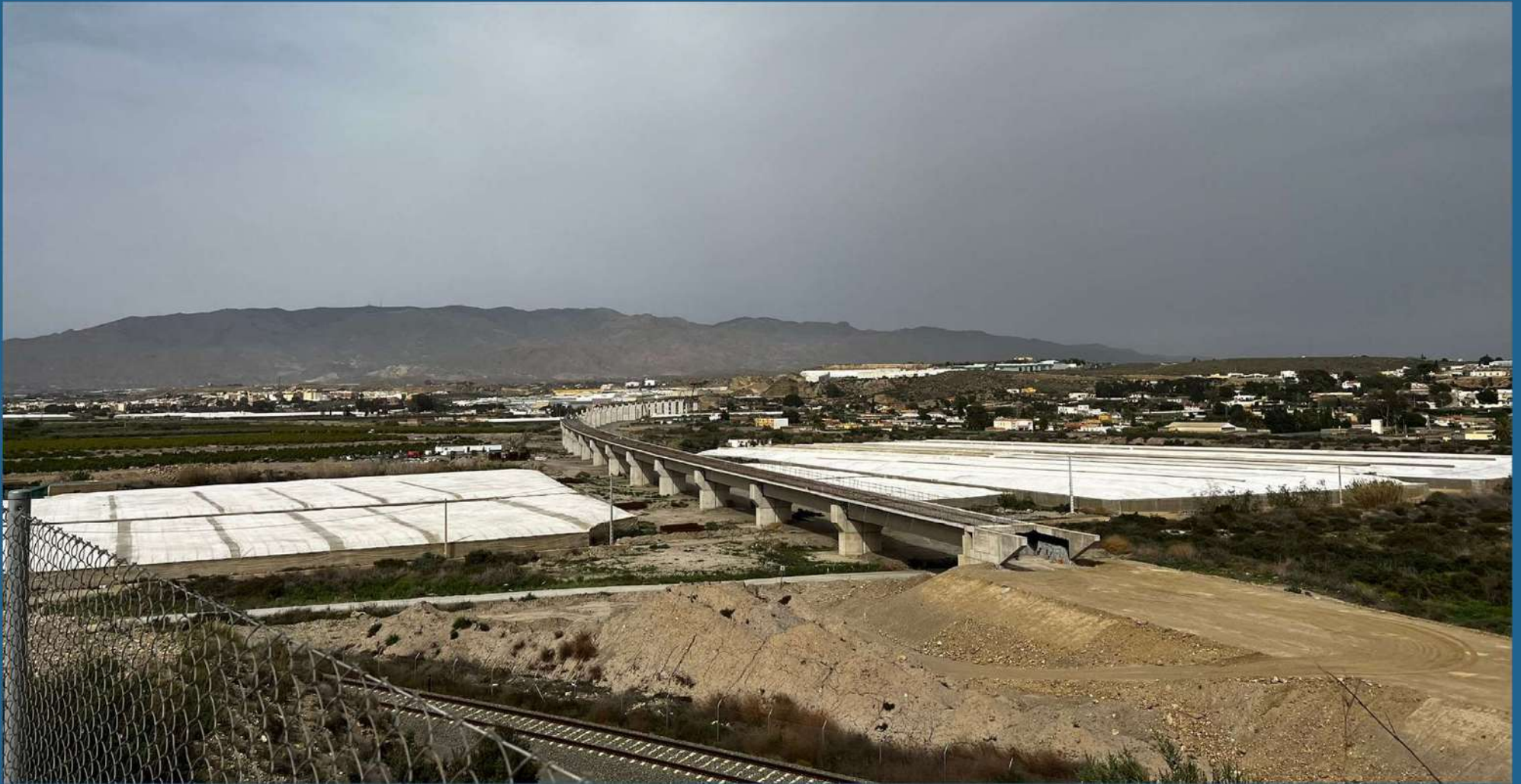
VIADUCTO SOBRE EL RIO ANDARAX 2
