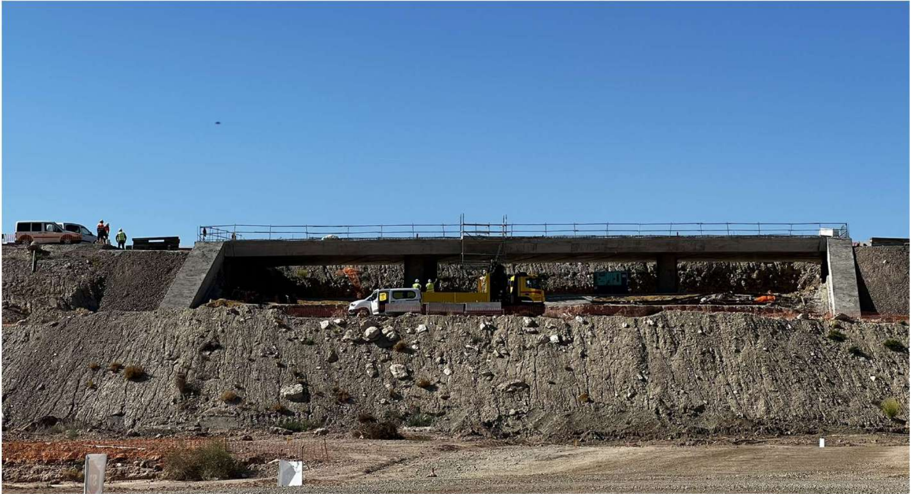
NUEVO PUENTE CARRETERA CIRCUNVALACIÓN PULPÍ
