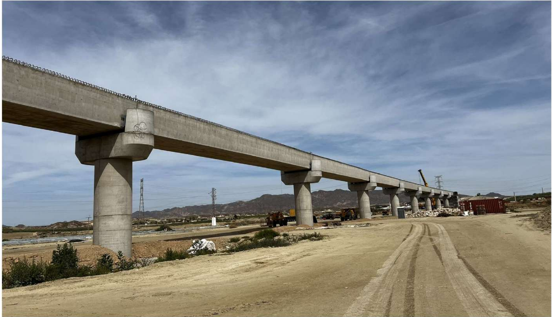
COLOCACIÓN DE VIGAS EN VIADUCTO
