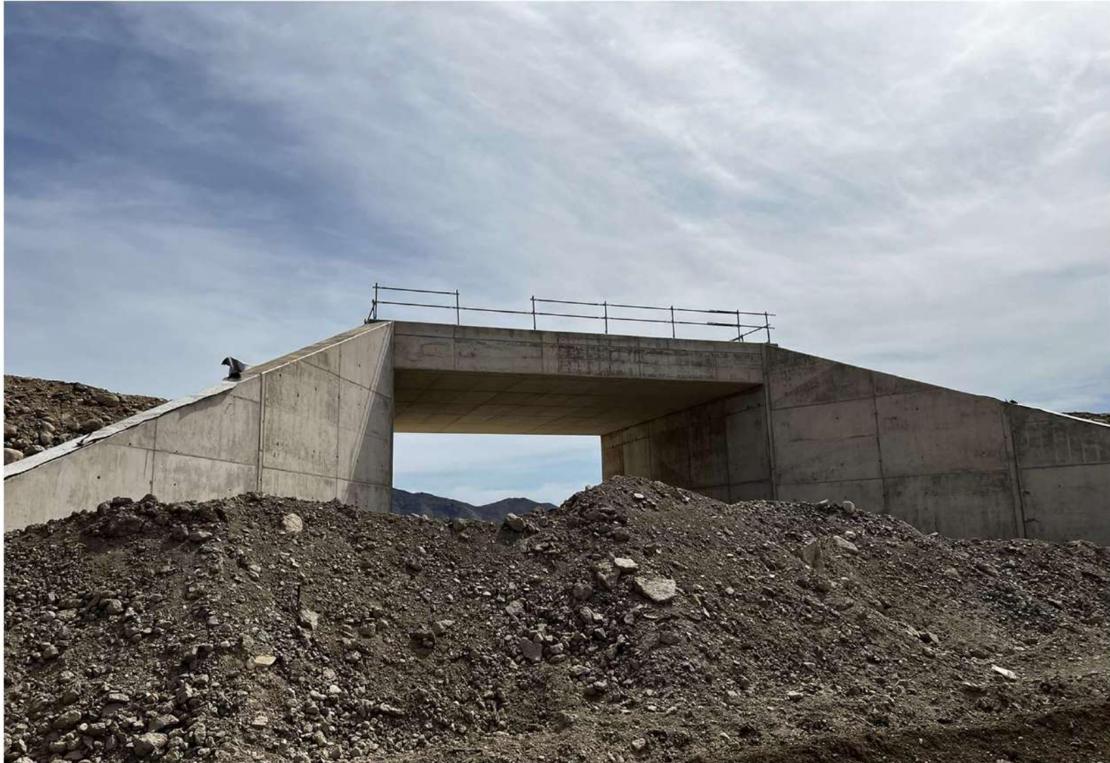
OBRA DE PASO_3
