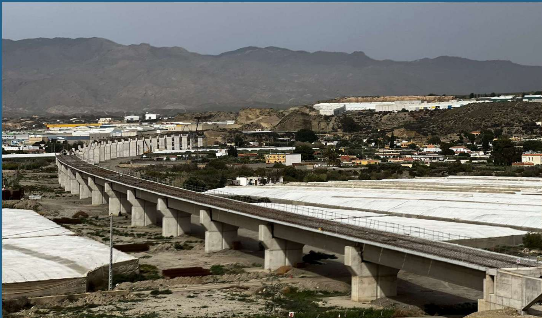
VIADUCTO SOBRE EL RIO ANDARAX
