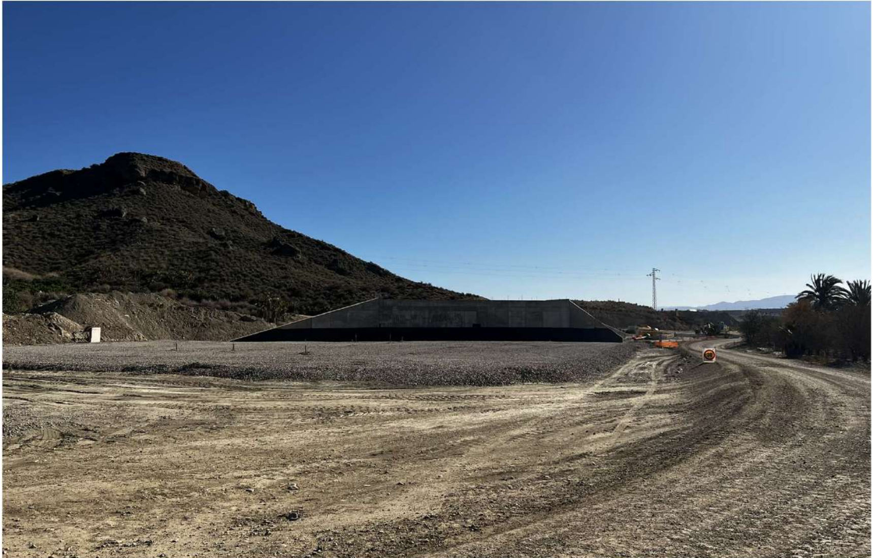
OBRA DE PASO_1
