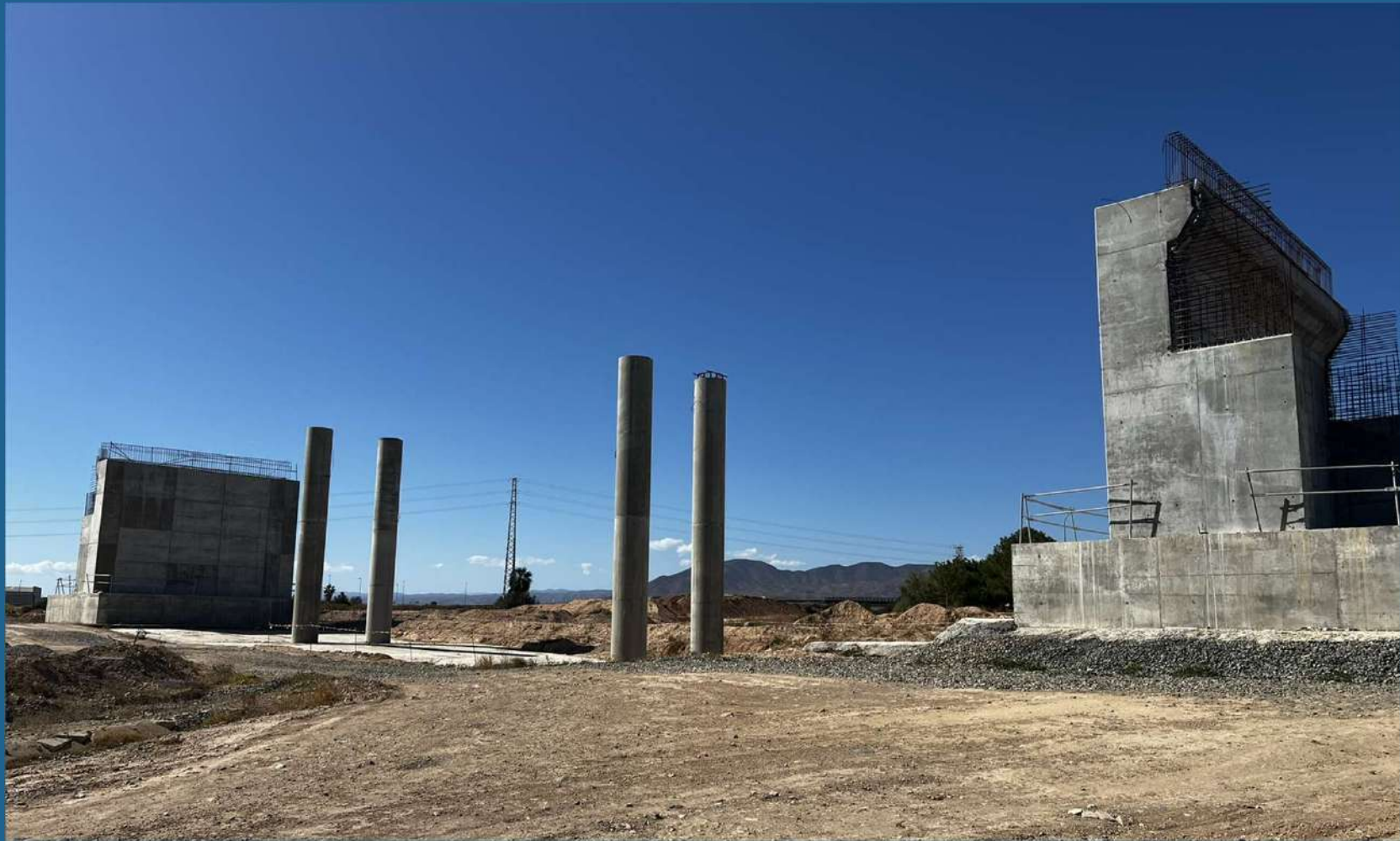
ESTRIBOS Y PILAS DE PUENTE JUNTO POLÍGONO PULPÍ
