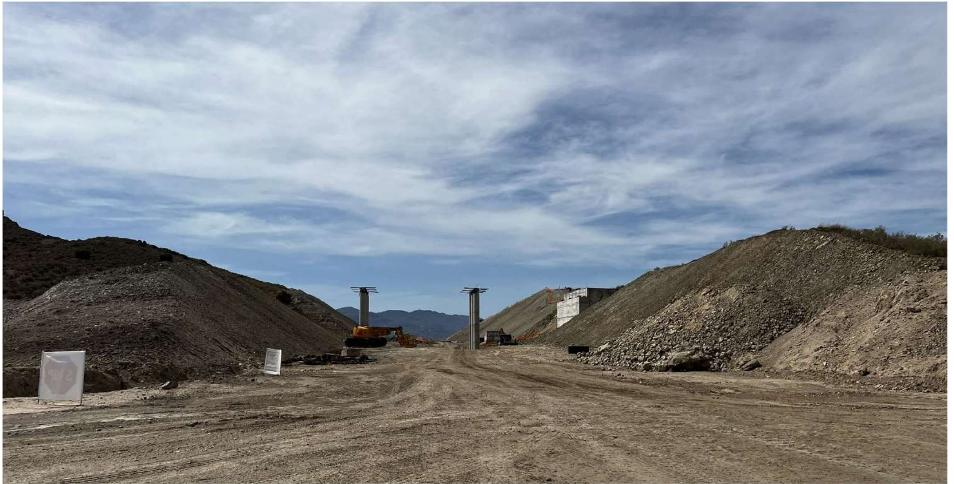
PUENTE SOBRE PLATAFORMA EN VERA
