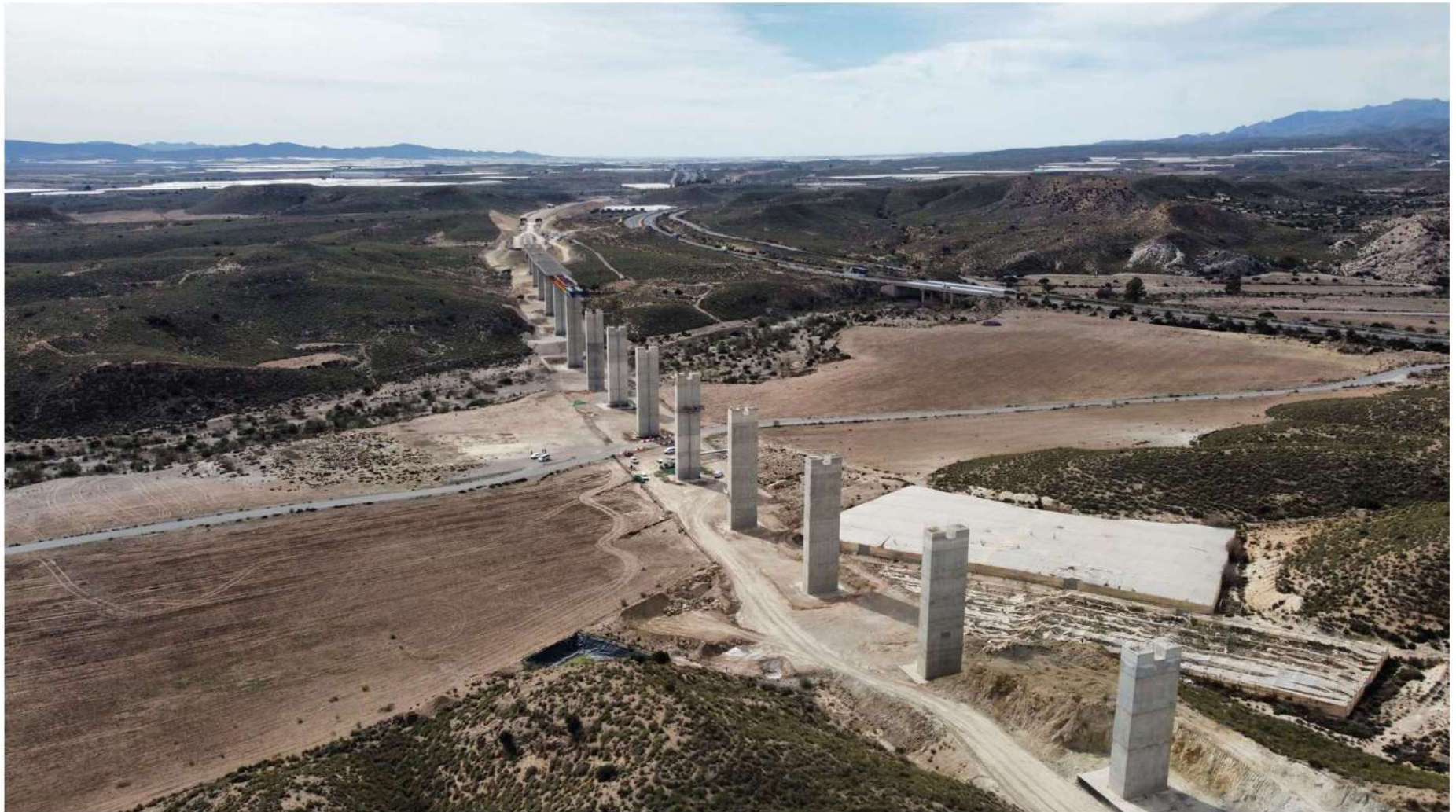
VIADUCTO RAMBLA DE LOS FEOS (3)
