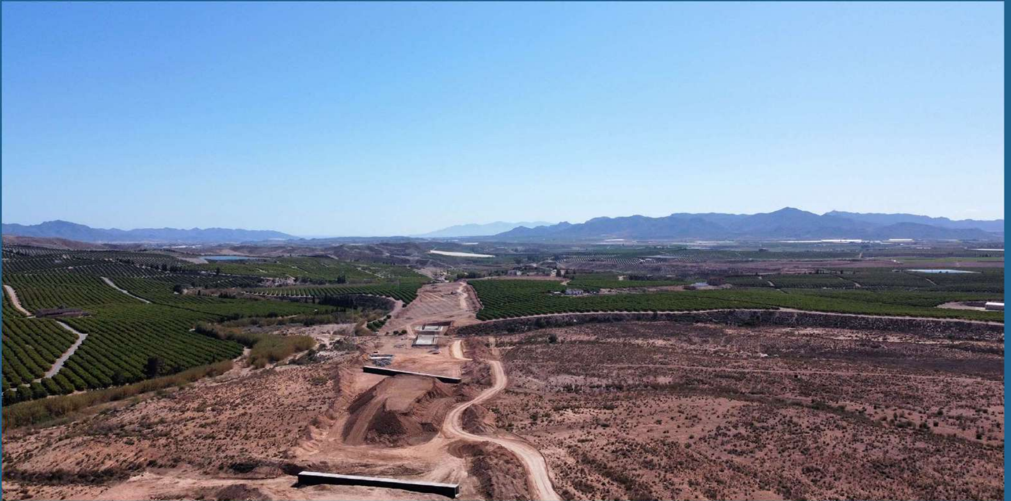
DE ALMENDRICOS HACIA ALMERÍA_INICIO DE VIADUCTO ARROYO DE LOS PELEGRINES
