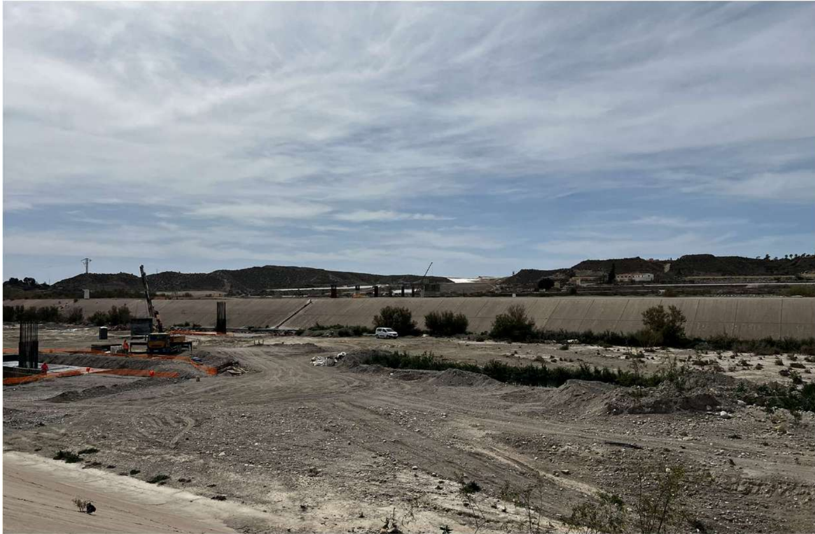
CIMENTACIÓN PUENTE SOBRE RÍO ALMANZORA_4
