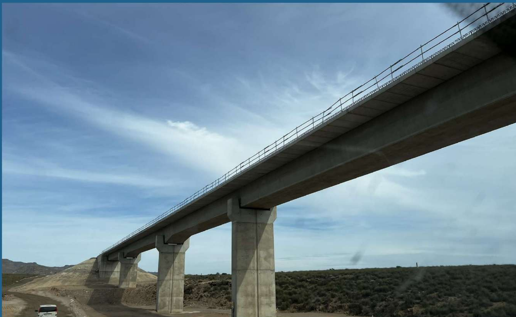
VIADUCTO SOBRE HOYA DE LA GITANA
