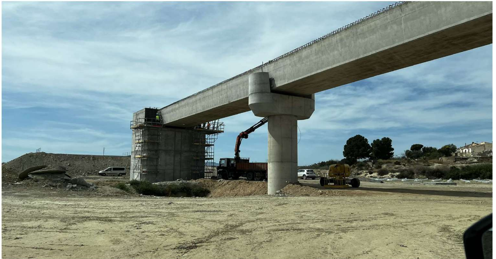
COLOCACIÓN DE VIGAS EN VIADUCTO_5
