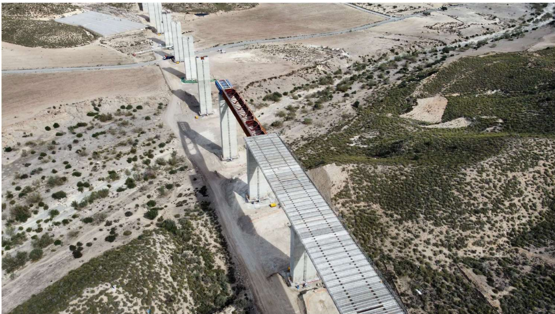
VIADUCTO RAMBLA DE LOS FEOS (7)
