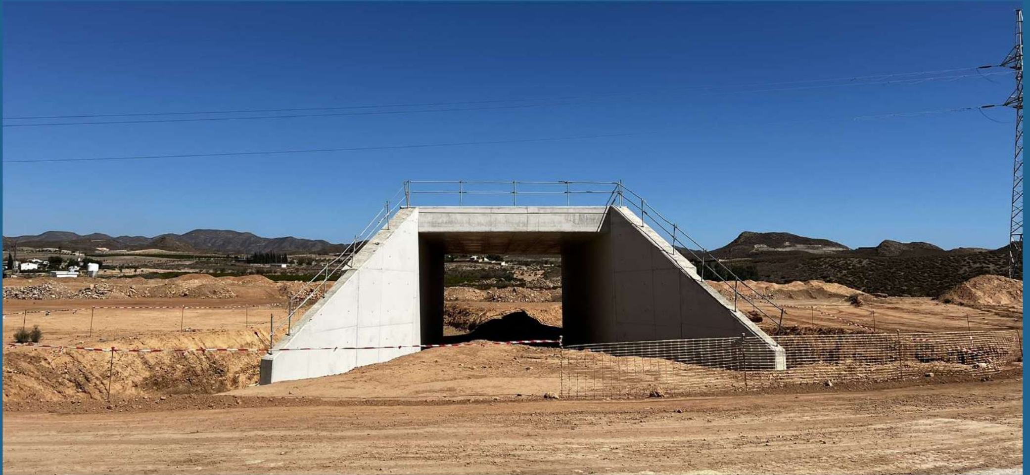
OBRA DE PASO
