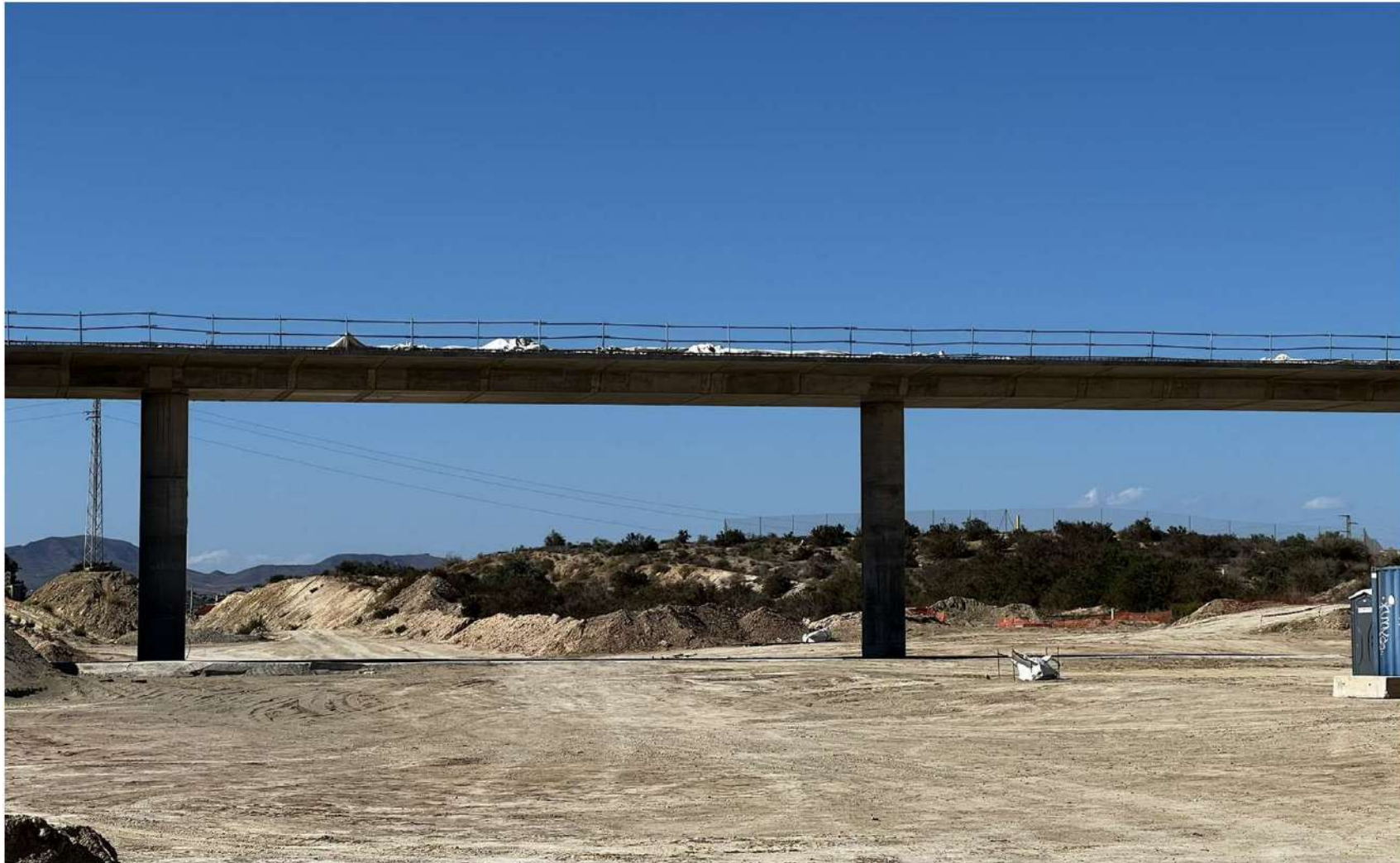
PUENTE SOBRE PLATAFORMA EN PUERTO
